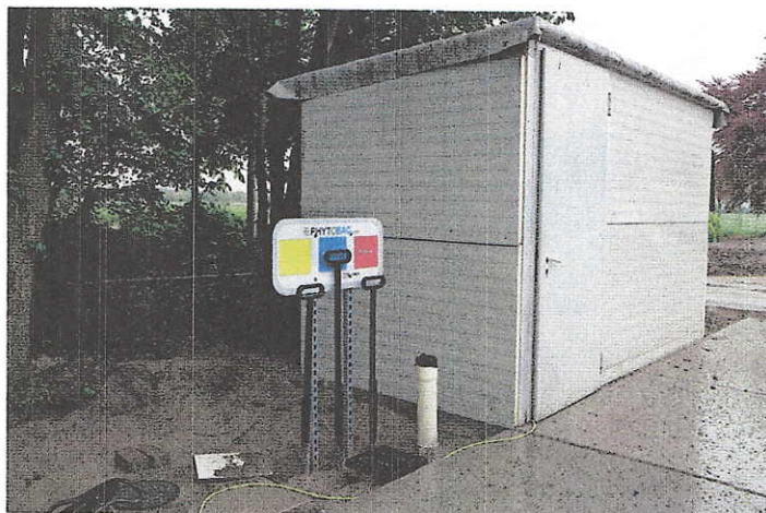
Via trekkhendels gaat de waterafvoer richting bezinkveld, phytobak of olie-afscheider. Ernaast het nieuwe middelenhok.
