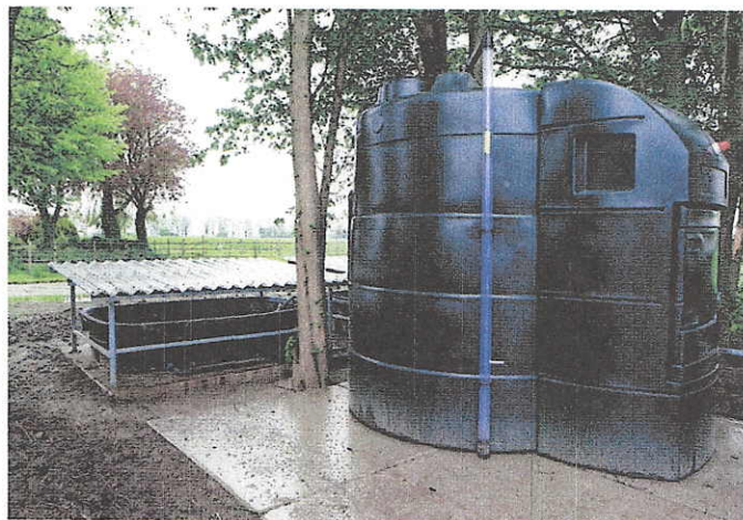
Een pompunit vernevelt de vloeistof met middelenresten over twee phytobakken.
