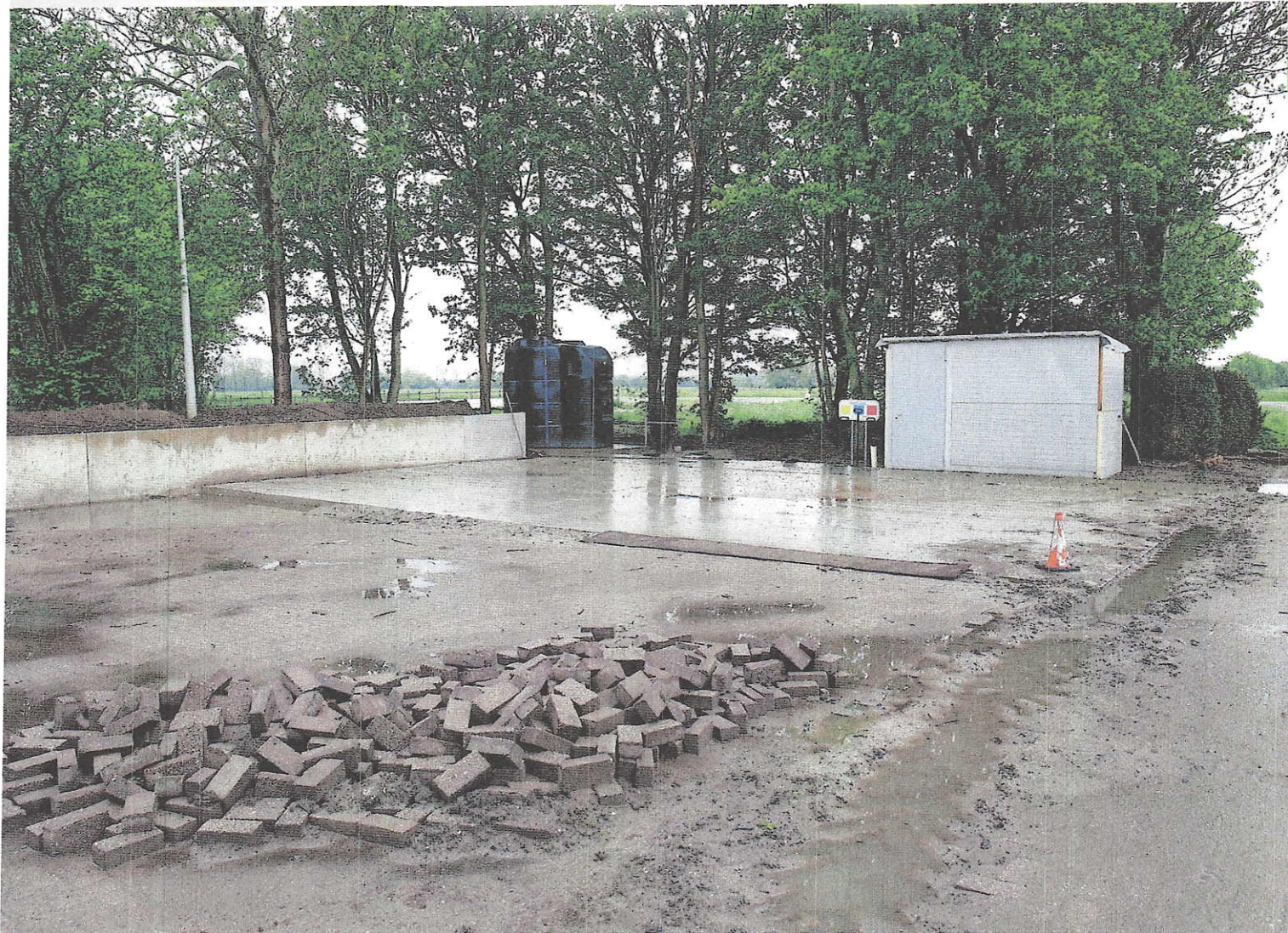
Mariëlle Keijzer legt een was- en vulplaats en een nieuw middelenhok aan.
